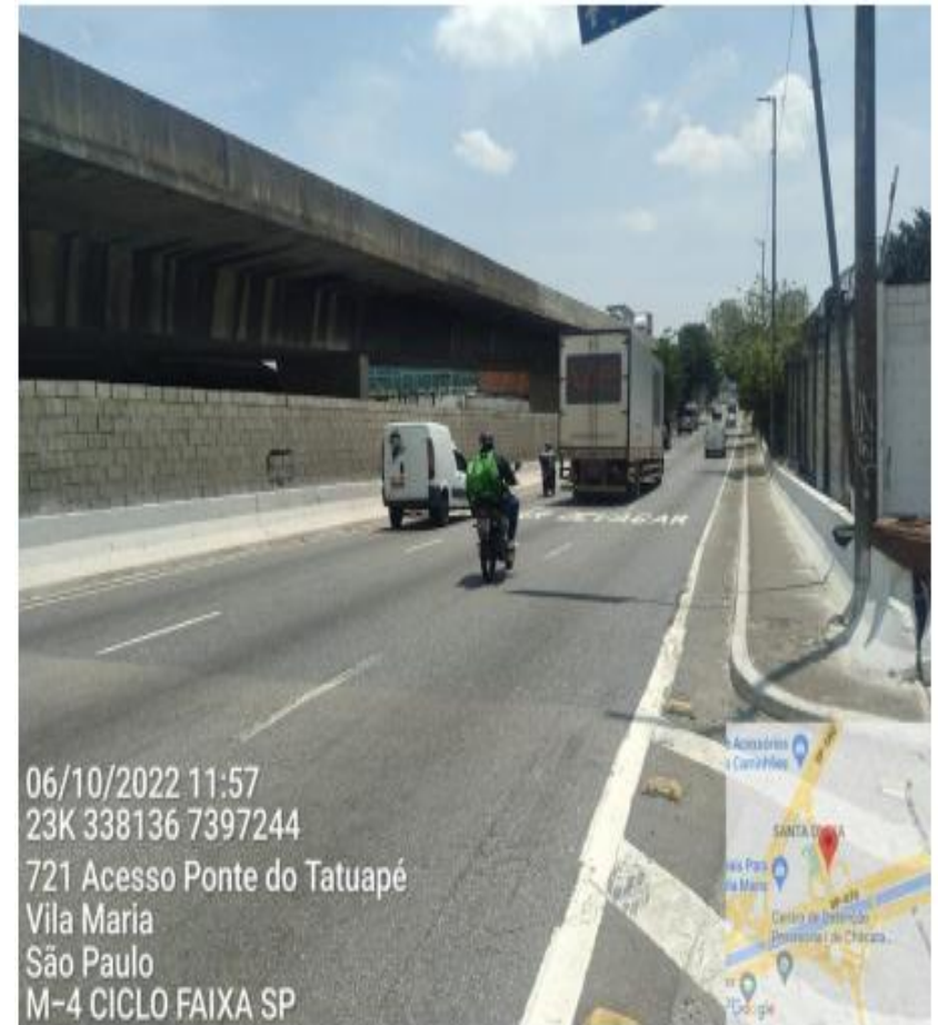
Acesso Ponte do Tatuapé
